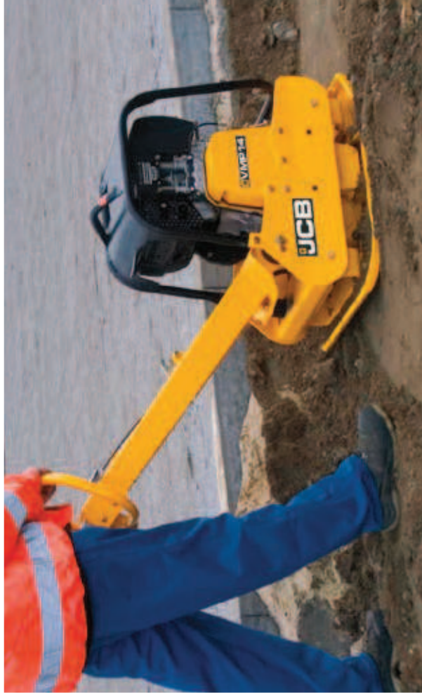
Mit Umkehr- und Standverdichtungsfunktion
